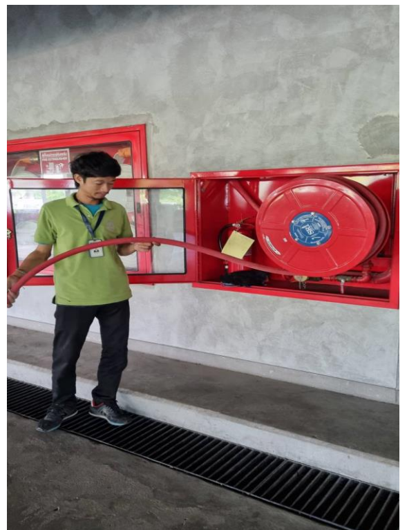
ตรวจสอบสายฉีดน้ำตู้ดับเพลิง
